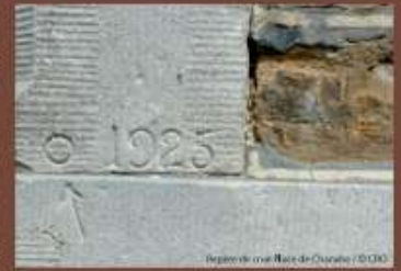
Repère de crue à la base de Courbeil © DOD
